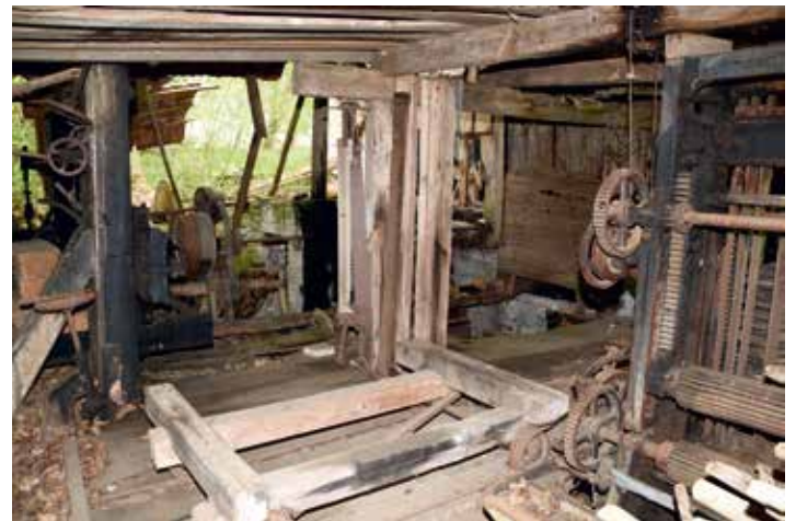
Aus heutiger „Hightech“-Sicht kaum mehr zu glauben ist die frühere Funktionstüchtigkeit der original aufbewahrten „Sägegatter“-Konstruktion (Bild) der Greiler-Mühle aus den 1950er Jahren mit spürbar verstärktem Wasserkraft-Antrieb durch einen händisch gegrabenen „Bypass“ des Kleeberger Baches von Hausmanning her. (Fotos: Nöbauer)
