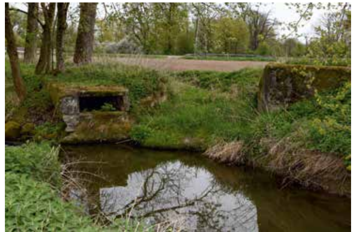
Mit einem eigens gefertigten Granit-Schacht (l.) wurde noch während der Nachkriegsjahre im seinerzeitigen Frimhöringer Sönning-Haus ein Stromaggregat betrieben.
